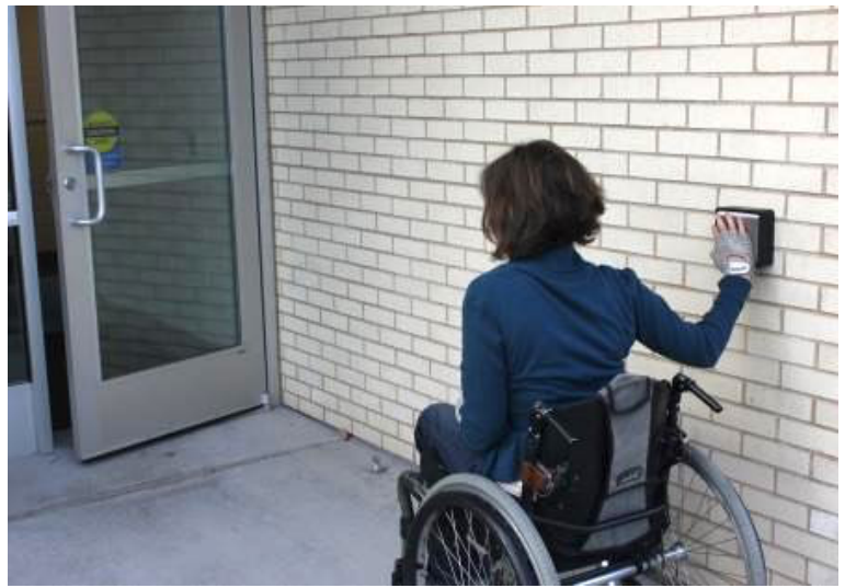
Automatisation du contrôle de porte.
